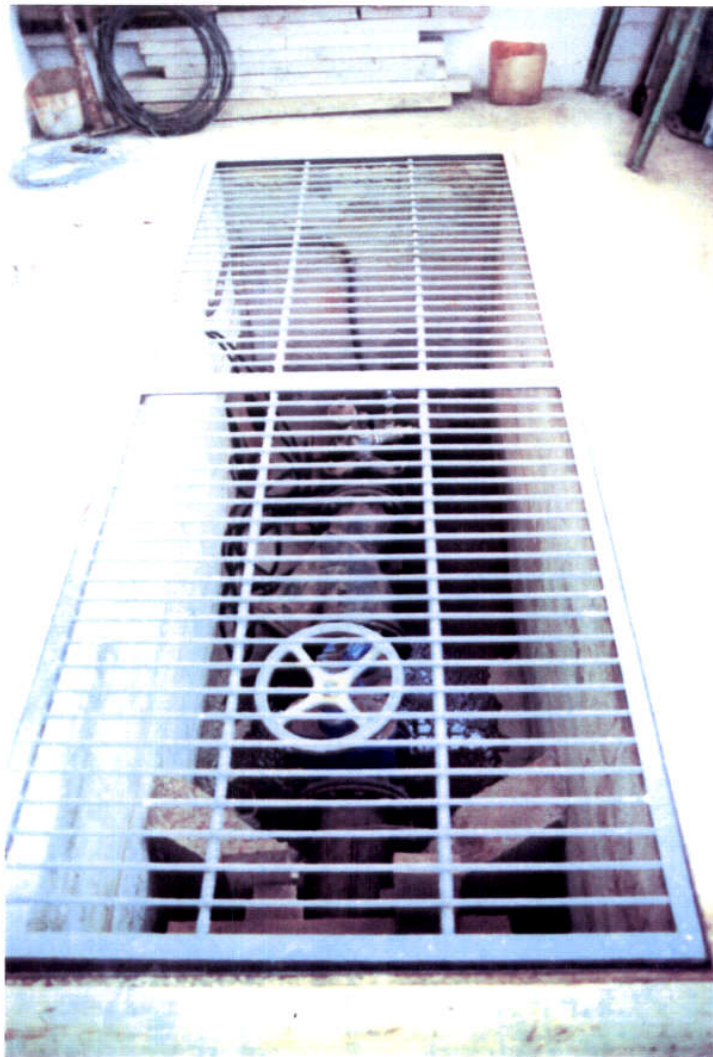
FOTO 4: Captación de aguas subterráneas.
