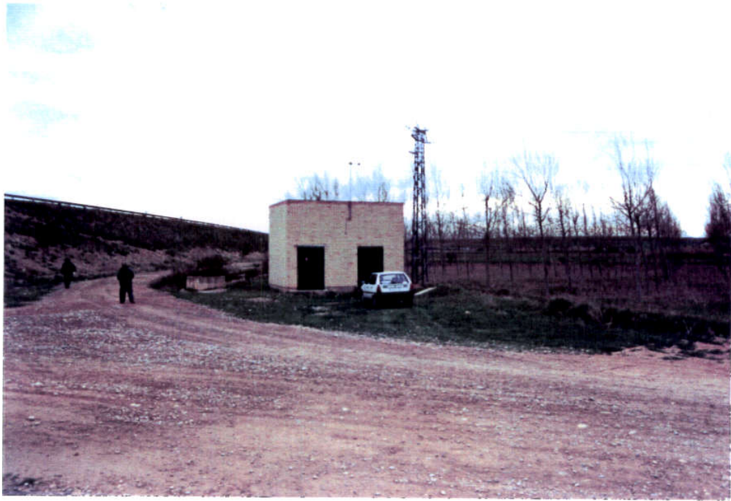
FOTO 3: Vista general de la captación de aguas subterráneas.
