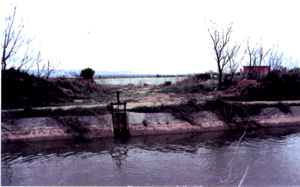
FOTO 1: Toma de aguas del Canal de Lodosa.
